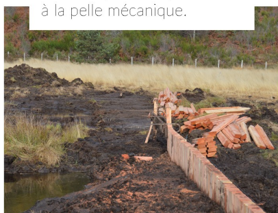
Mise en place de palissades à la pelle mécanique.
