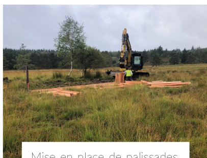
Mise en place de palissades à la pelle mécanique.
